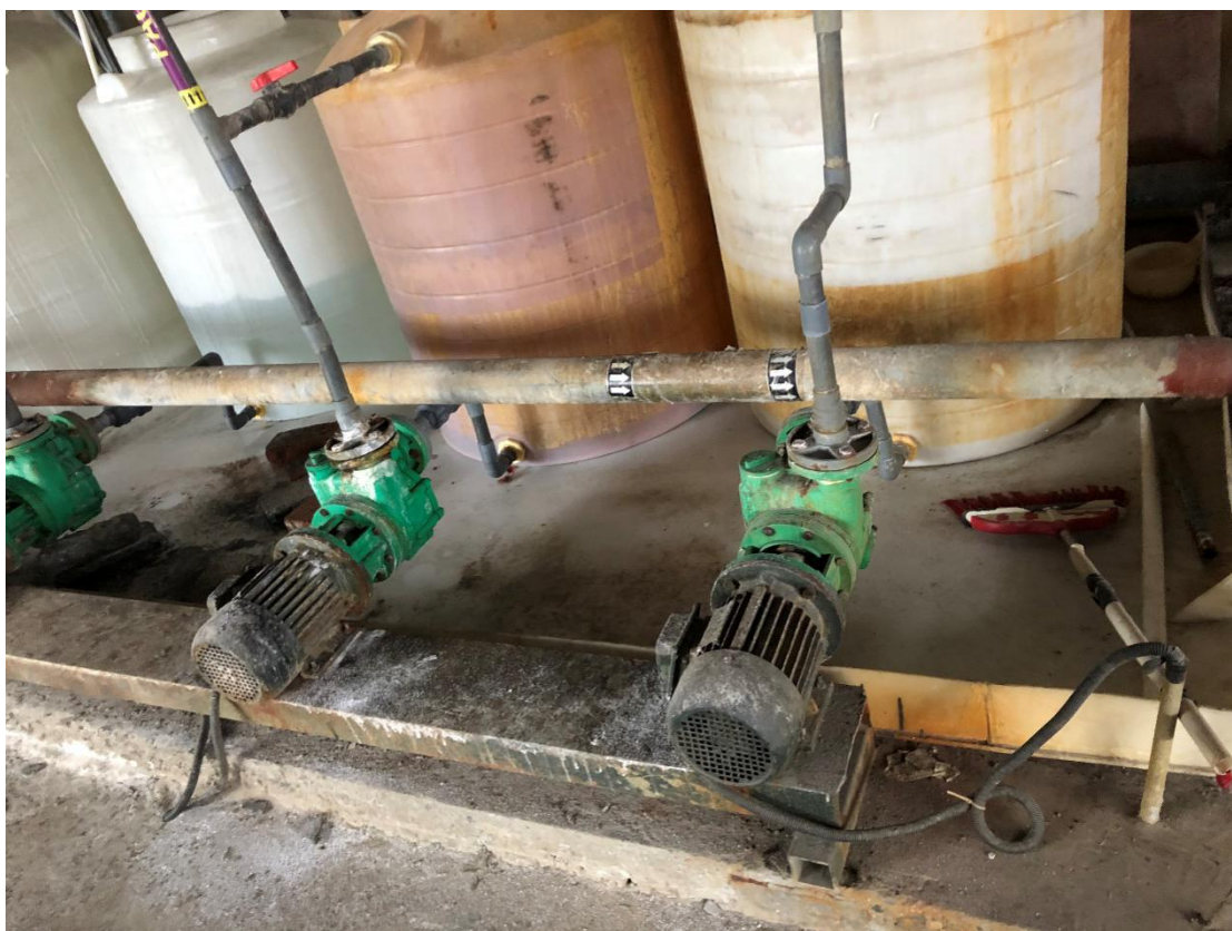
图 6.4-1 废水处理设施围堰
