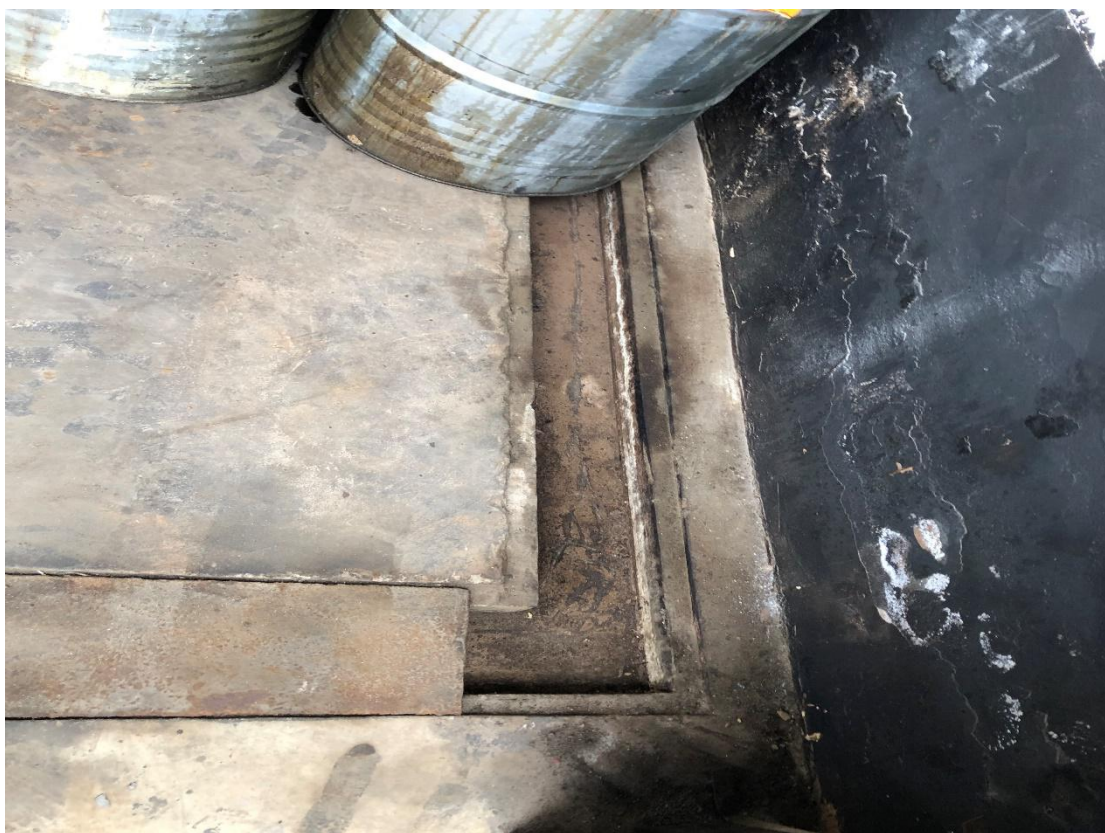
图 6.3-3 危废仓库导流沟
