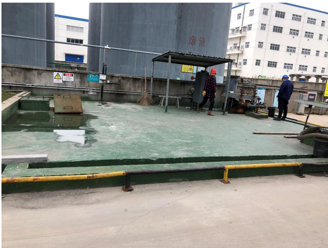
图 6.2-2 装卸区导流沟
